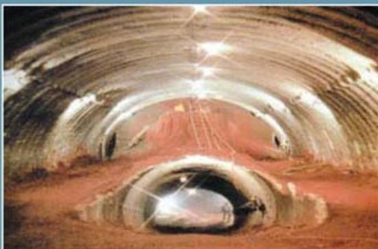
Foto 3 - Vista do túnel de acesso à calota superior da estação Brigadeiro durante a construção (CBT, 2006)
