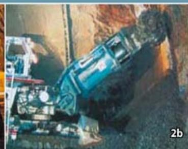
Foto 2b – Escavação com Fresa na Estação Subterrânea Exchange Place – Jersey City, NJ, 2002
