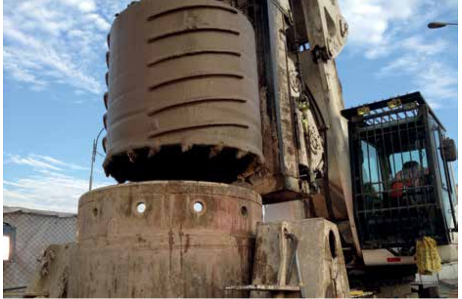
Figura 5 – Detalhe da ferramenta de perfuração, escarificação, corte e trituração do conglomerado local. Entra por dentro do tubo camisa de revestimento do furo
