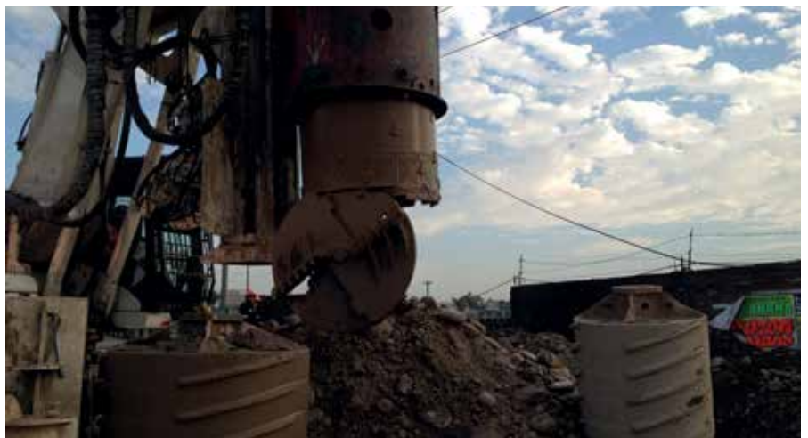
Figura 7 – Detalhe do equipamento de abertura da tampa do cilindro coletor de detritos do furo, abrindo a tampa inferior por sistema de encaixe
