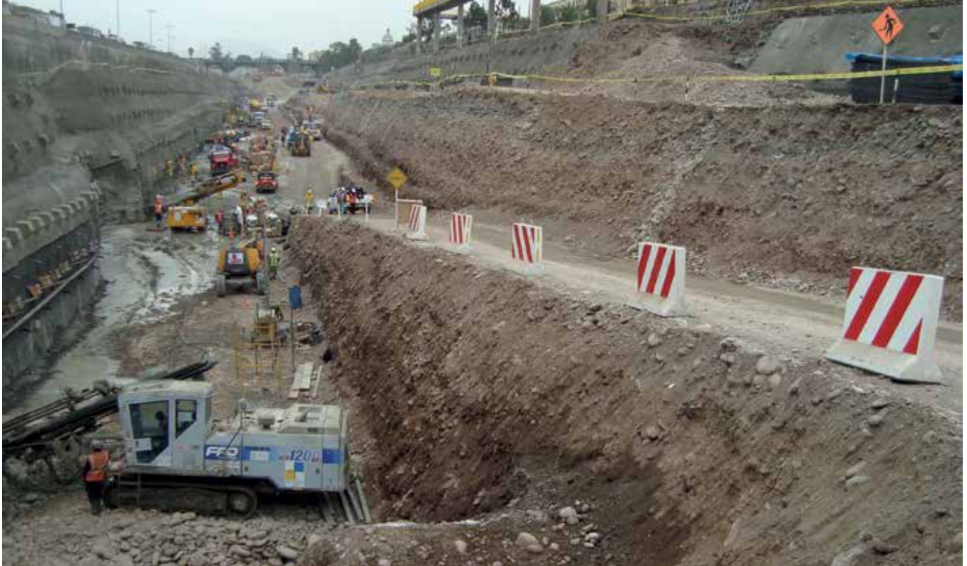
Figura 1 – Vista geral de comportamento estável de taludes e perfurações de ancoragens passivas no leito do rio Rímac
