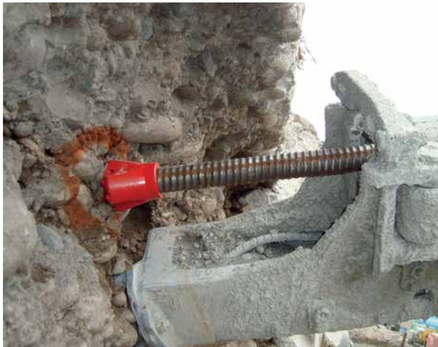
Figura 2 – Detalhe de ancoragem passiva autopercussora
