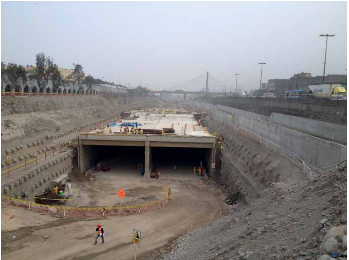
Figura 4 – Detalhe do canal provisório, à direita da foto, os taludes com contenção em solo grampeado e a execução de parte do módulo do túnel
