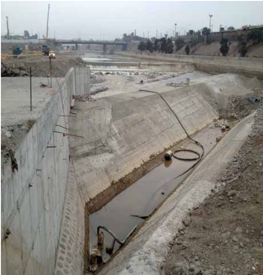
Figura 9 – Detalhe dos diques para retenção de blocos e desvio do rio
