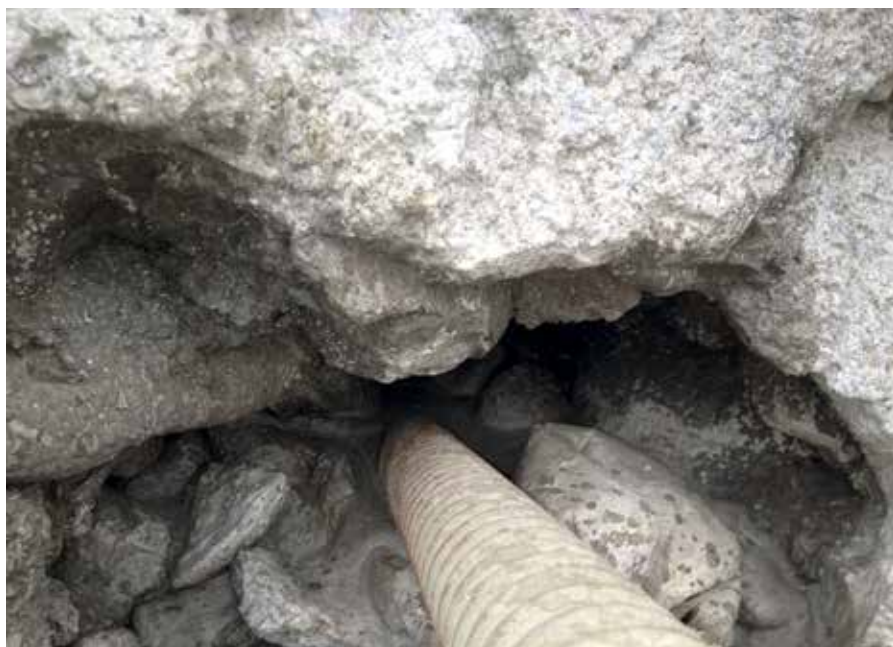
Figura 3 – Detalhe da sobre escavação ocorrida pela utilização de água sob pressão no processo. A perfuração foi revista para uso de calda de cimento diluída, e sua estabilidade foi visivelmente superior
