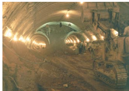
Túnel em NATM em construção - JB Guaianazes - São Paulo/SP.
