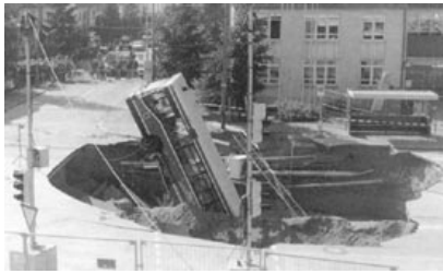
Colapso de Túnel em Munique, Alemanha - 1994 (Anderson, 1997a).
