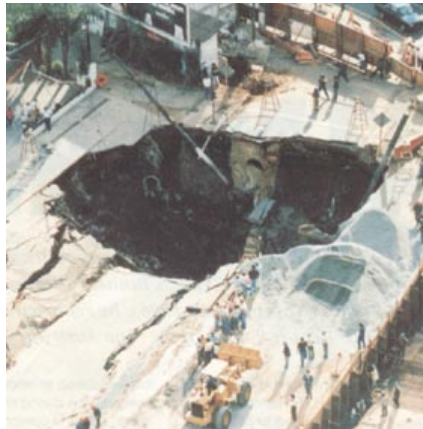
Colapso de túnel em São Paulo, Brasil - 1993 (Anderson, 1997a).
