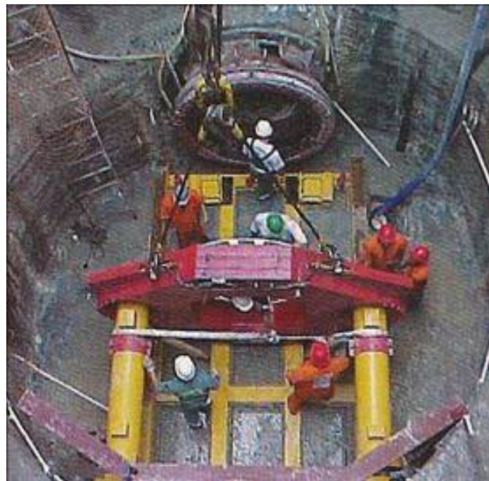
Foto 10 - Outro exemplo de poço de cravação em operação
