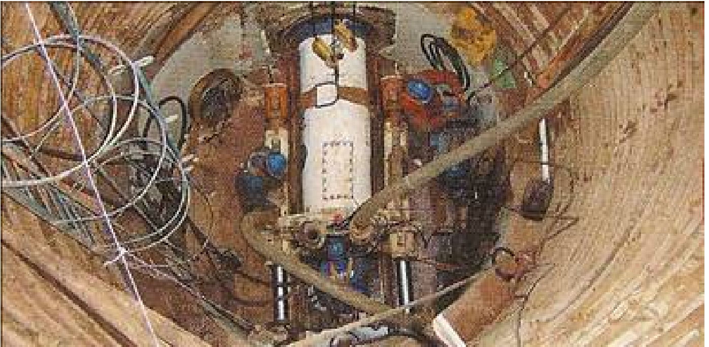
Foto 7 - Cravação em Poço Circular
