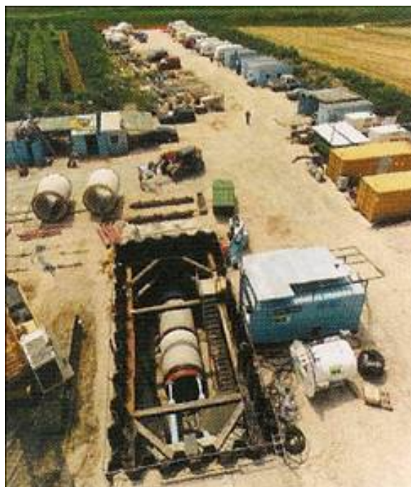
Foto 6 - Vista de cravação em vala retangular
