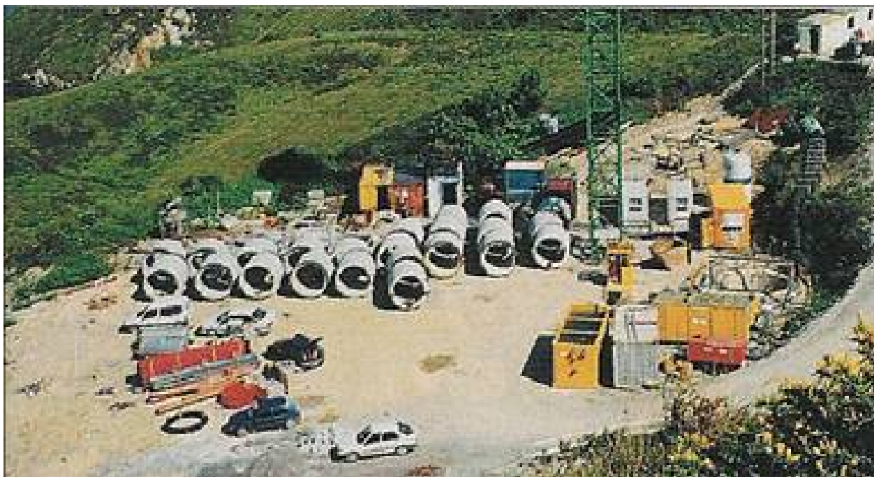
Foto 5 - Vista de canteiro de obra com estoque de tubos pré fabricados
