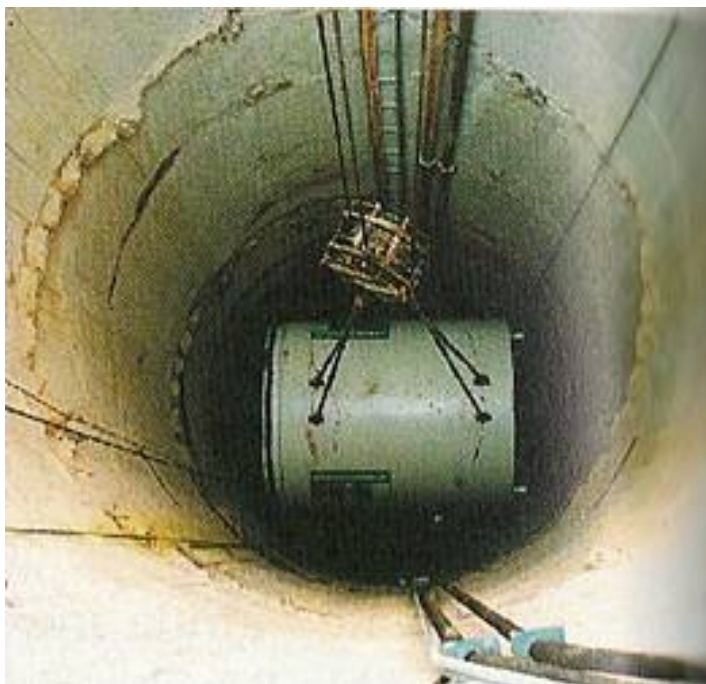
Foto 3 - Descida de Máquina dentro de Poço de Partida
