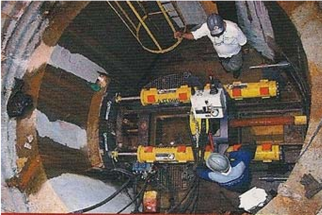
Foto 13 - Aplicação de Reação para Cravação em Parede de Poço Circular
