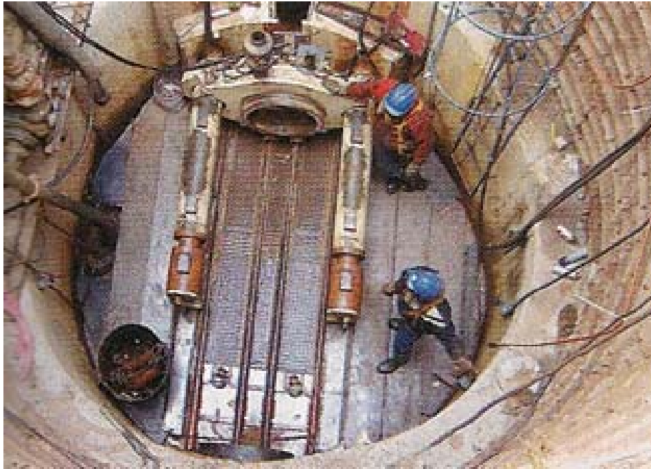
Foto 9 - Exemplo de Poço de Cravação em Operação
