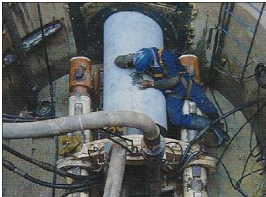
Foto 4 - Início da Cravação de Tubo Pré Fabricado
