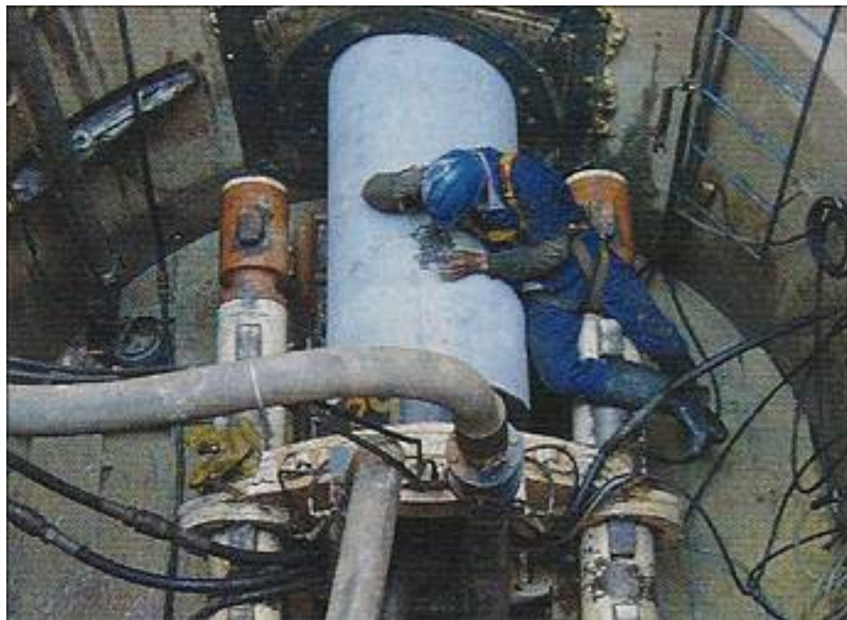
Foto 16 – Detalhe Típico de Cravação de Tubo Pré Fabricado em obra de Coletor Tronco
