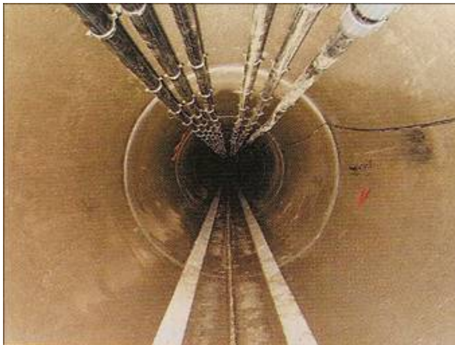
Foto 12 - Túnel em Execução com Revestimento Instalado. Notar estanqueidade das juntas dos tubos cravados.
