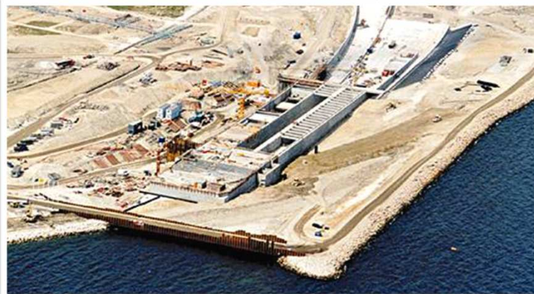
Figura 11 – Execução da estrutura de aproximação a seco.
