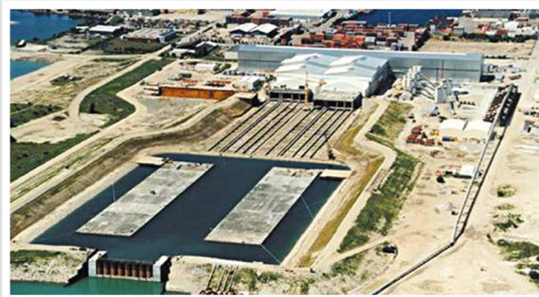
Figura 5 – Fase de Inundação da doca seca.
