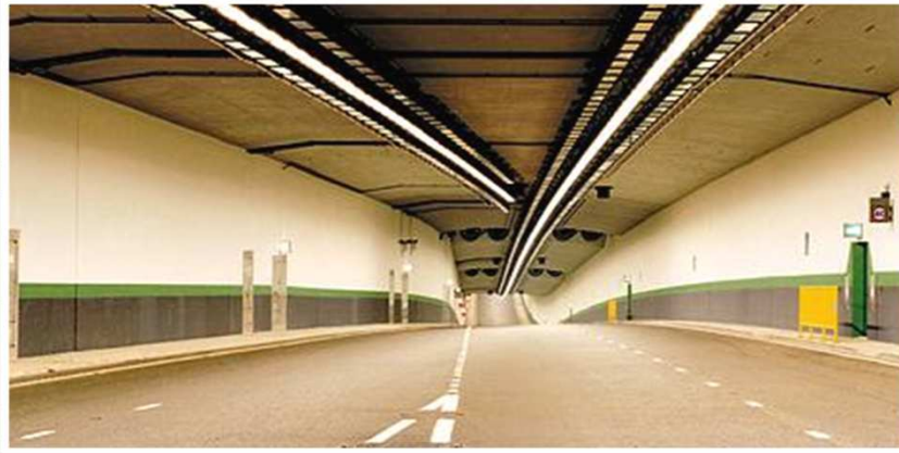
Figura 12 – Aspecto final do túnel acabado.
