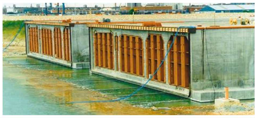
Figura 4 – Vedação temporária dos elementos.
