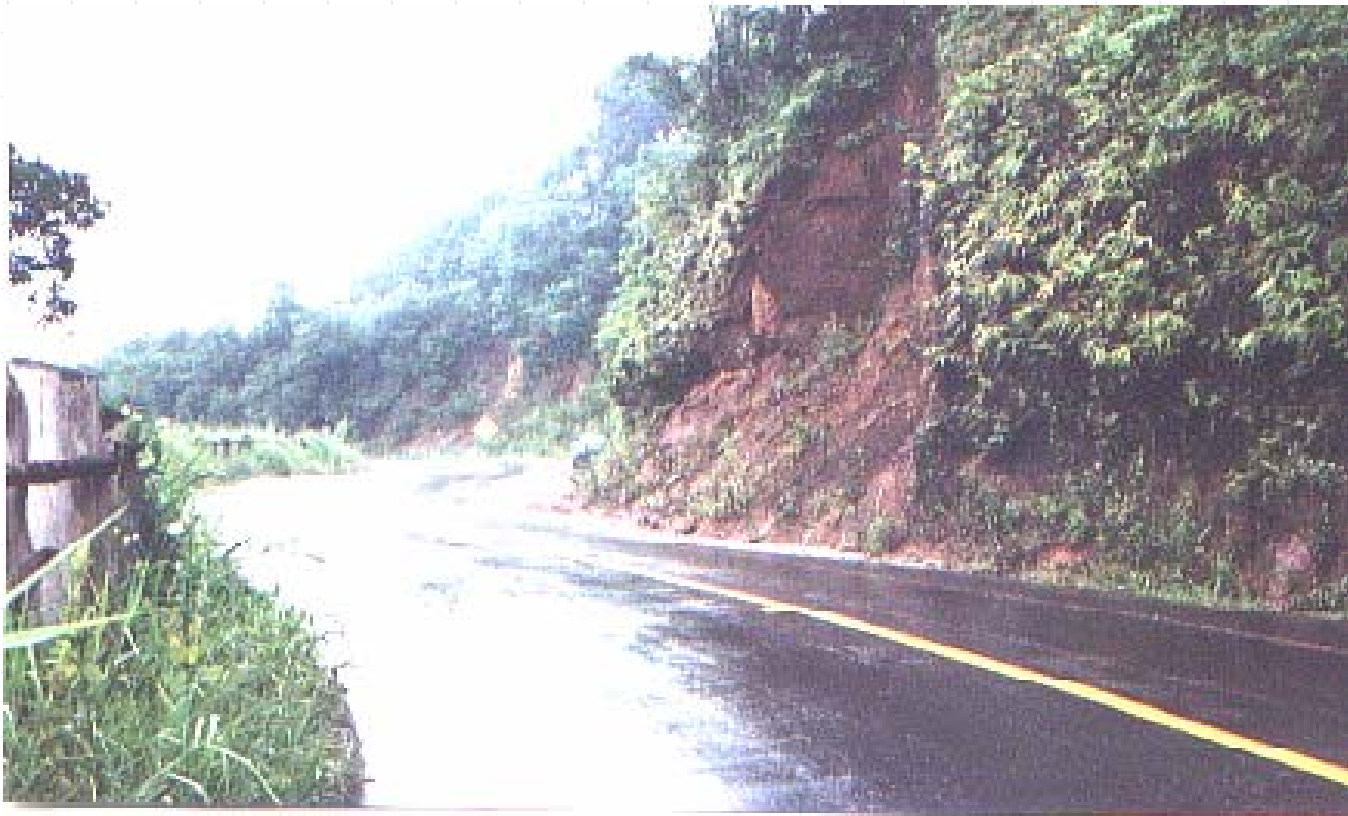
Foto 2 – Corte subvertical no solo de alteração
