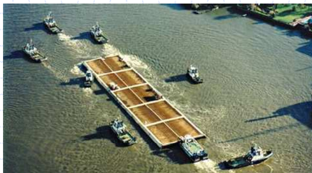
Figura 6 – Transporte do elemento até o local de instalação (Tribune, 1999)
