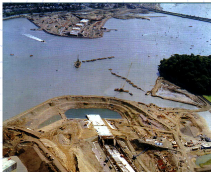
Vista geral do canteiro de obras (Tribune, 1999)
