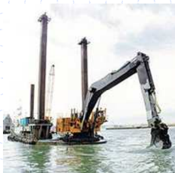
Figura 2 – Abertura da trincheira (Tribune, 1999)
