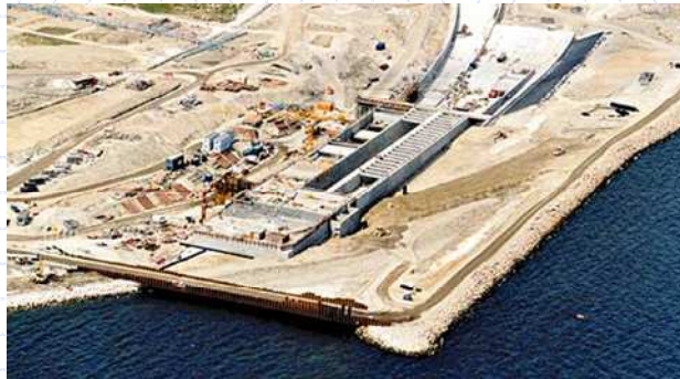
Figura 11 – Execução da estrutura de aproximação a seco (Tribune,1999)
