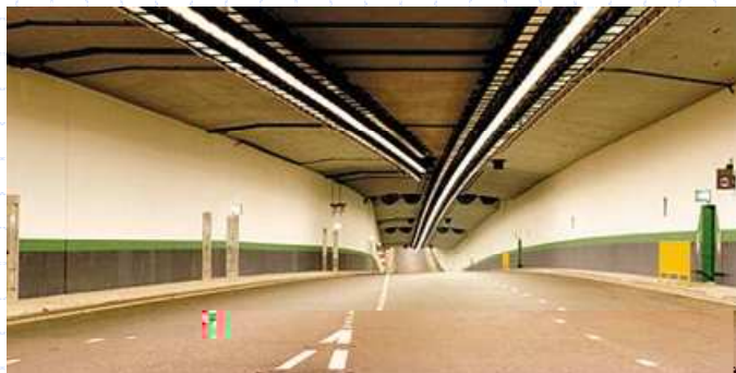
Figura 12 – Aspecto final do túnel acabado (Tribune,1999)
