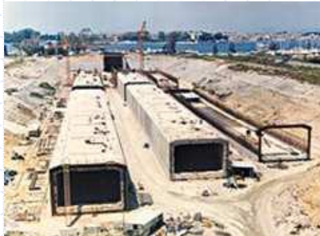
Figura 3 – Fabricação dos elementos em uma doca seca (Tribune, 1999)
