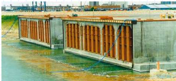
Figura 4 – Vedação temporária dos elementos (Tribune, 1999)
