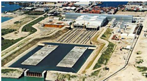
Figura 5 – Fase de Inundação da doca seca (tribune, 1999)
