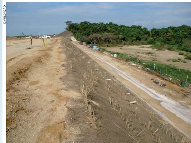
Borda da plataforma do Cracker, mostrando proteção de talude contra erosão e bombas de vácuo (em verde) no nível inferior
