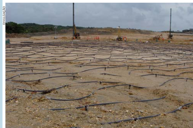
Cravação de drenos e tubulação para aplicação de vácuo para aceleração de recalques
