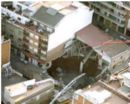
Figura 5 - Colapso em túnel em construção na Suíça
