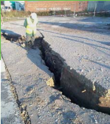
Figura 9 - Colapso do túnel Hull (interceptor de esgotos), Inglaterra, 1999: recalques excessivos e ruptura do maciço acima do túnel
