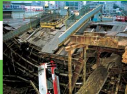
Figura 10 - Colapso do Metrô de Taegu (Cut and Cover), Coreia do Sul, 2000
