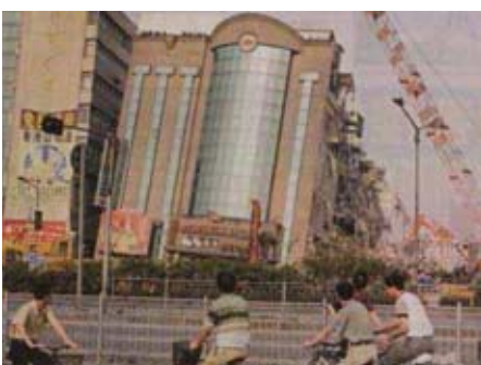
Figura 12 - Outro Colapso no Metrô de Shanghai, China, 2003
