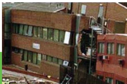
Figura 7 - Colapso de edificação subsequente ao colapso dos túneis de Heathrow (1994)
