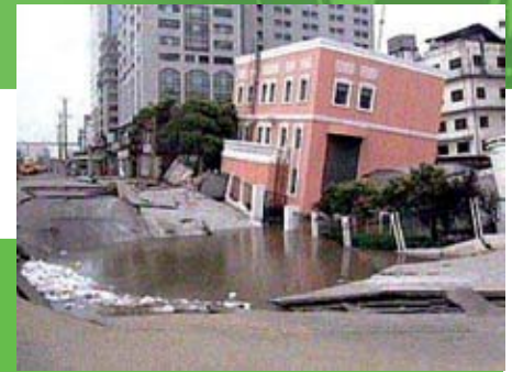
Figura 11 - Colapso do Metrô de Shanghai, China, 2003
