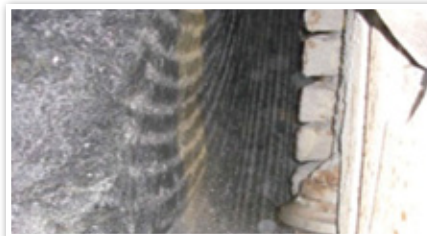
Foto 6 - Redução de temperatura da frente de escavação com água
