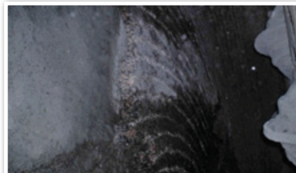
Foto 7 - Detalhe de planos de fraturamento e como são quebrados.
