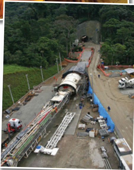
Foto 9 a 19 - Ilustram diversas etapas de construções de túneis em rocha com escavação mecanizada.
