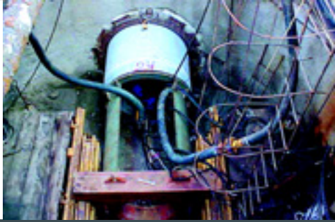
Cravação de tubo pré-moldado a partir do poço de emboque
