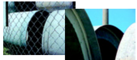
Detalhe do encaixe entre tubos para Pipe Jacking e entre segmentos de tubo cravado
