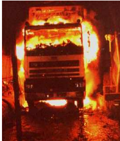
Figura 3 – Ejemplo de incendio en túnel vial
