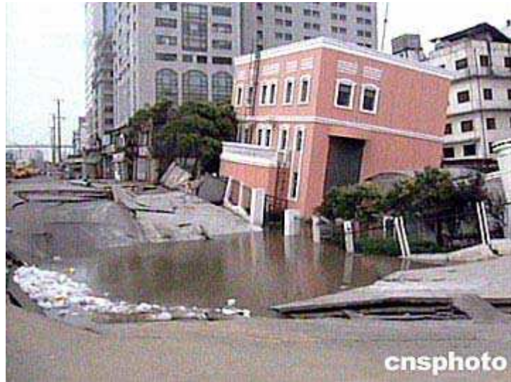
Figura 11 – Colapso del Metro de Shangai, China, 2003
