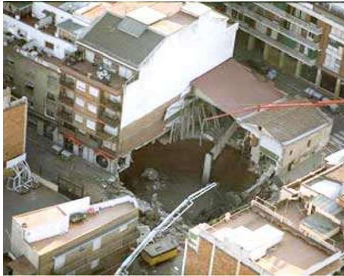
Figura 5 – Colapso en túnel en construcción en Suiza
